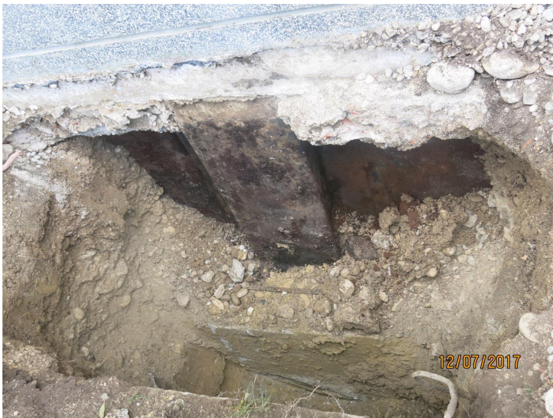
Slika 49: Točkovni temelj pod AB stebrom; izmerjene dimenzije b=1,0 m, h=0,8 m, ustrezajo projektu; steber in greda sta hidroizolirana
