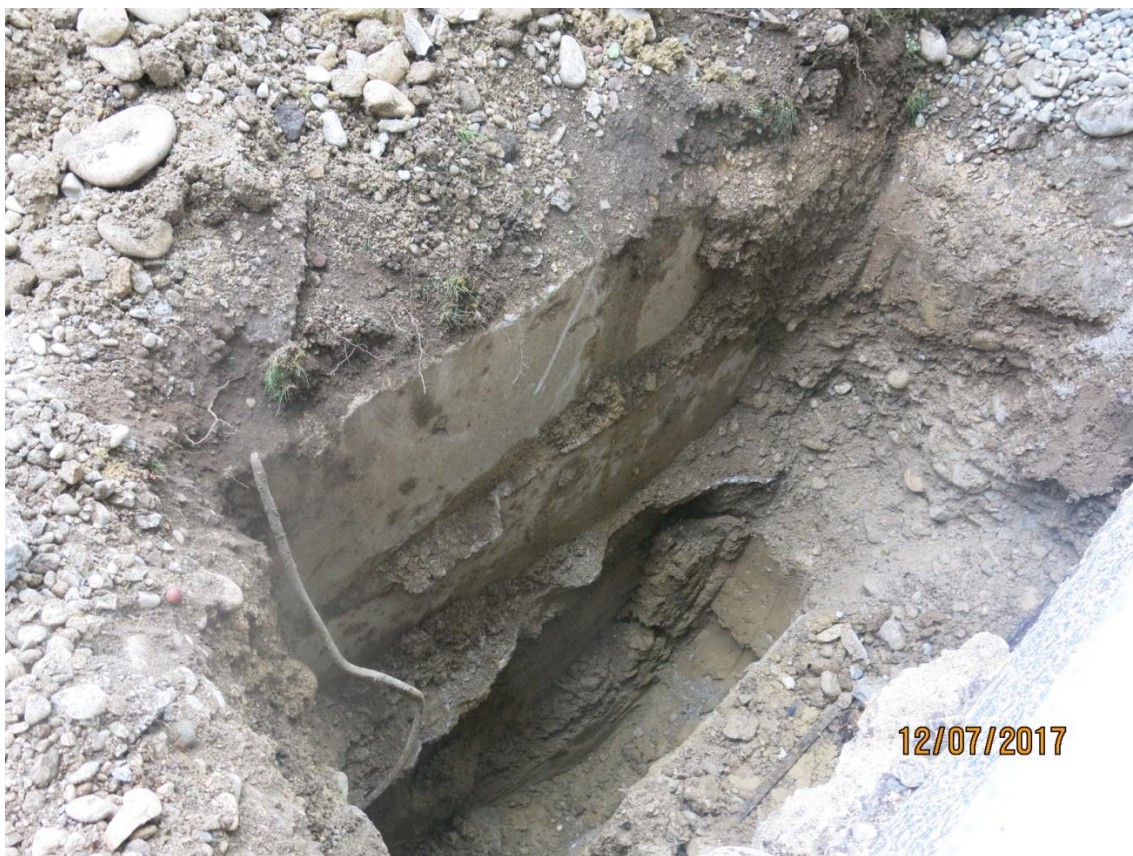
Slika 50: Zunanja stran izkopa - vidna stena kinete
