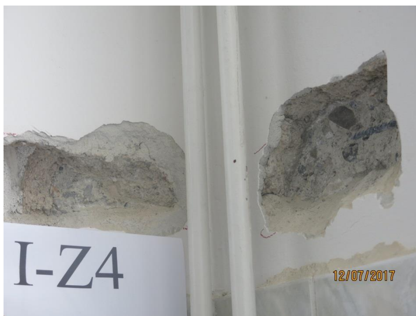
Slika 20: Vrtina pokaže, da je stena betonska
