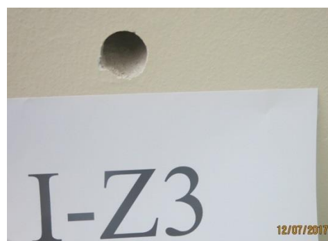
Slika 20: Vrtina pokaže, da je stena betonska
