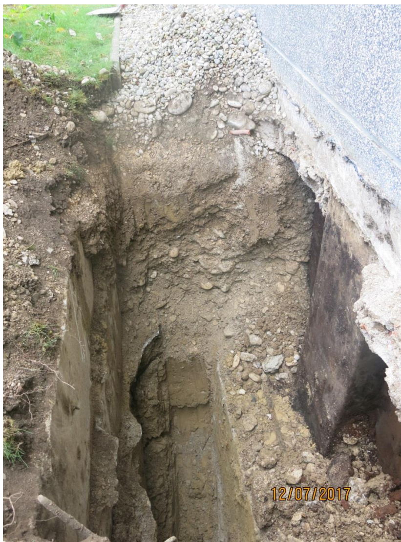
Slika 48: Sondažni izkop ob obstoječem temelju pod AB stebrom v osi C/1 na SZ strani objekta; dno temelja na globini ca -2,40 m; viden prodno-peščeni zasip temelja in sivorjavi melji v težkognetni konsistenci na dnu izkopa
