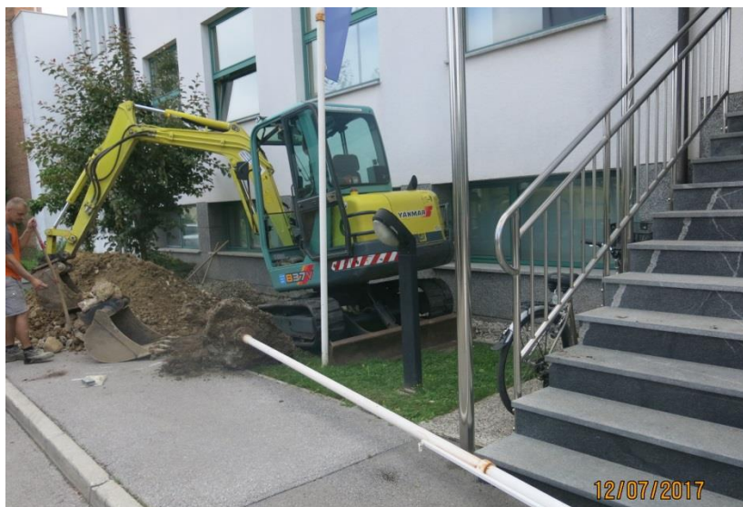
Slika 47: Sondažni izkop ob obstoječem temelju pod AB stebrom v osi C/1 na SZ strani objekta;
